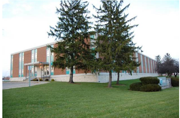
Ohio Bell Telephone Co. 3233 Woodman Dr., Kettering
